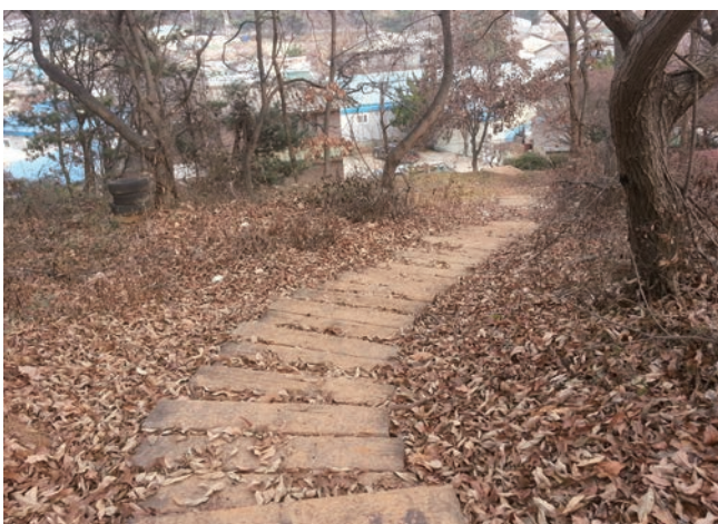
서하공 묘역 오르는 계단 정비공사
