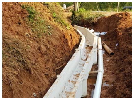
개곡리 사택 뒤 수해복구 공사
