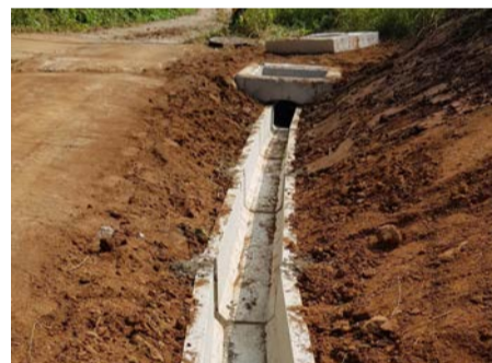
개곡리 사택 뒤 수해복구 공사
